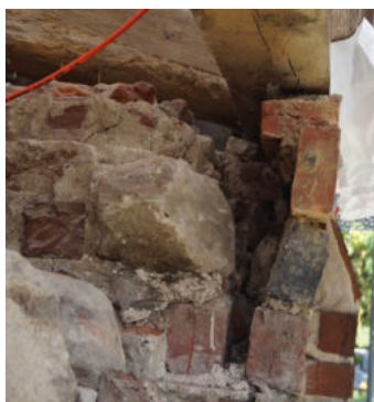
Die äußere Schicht der Apsis ist abgerissen und neigt sich gefährlich nach Osten. (Bild re.)
